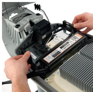
Evolutivité aisée d'une version HID vers une version LED (installez la platine appareillage)
