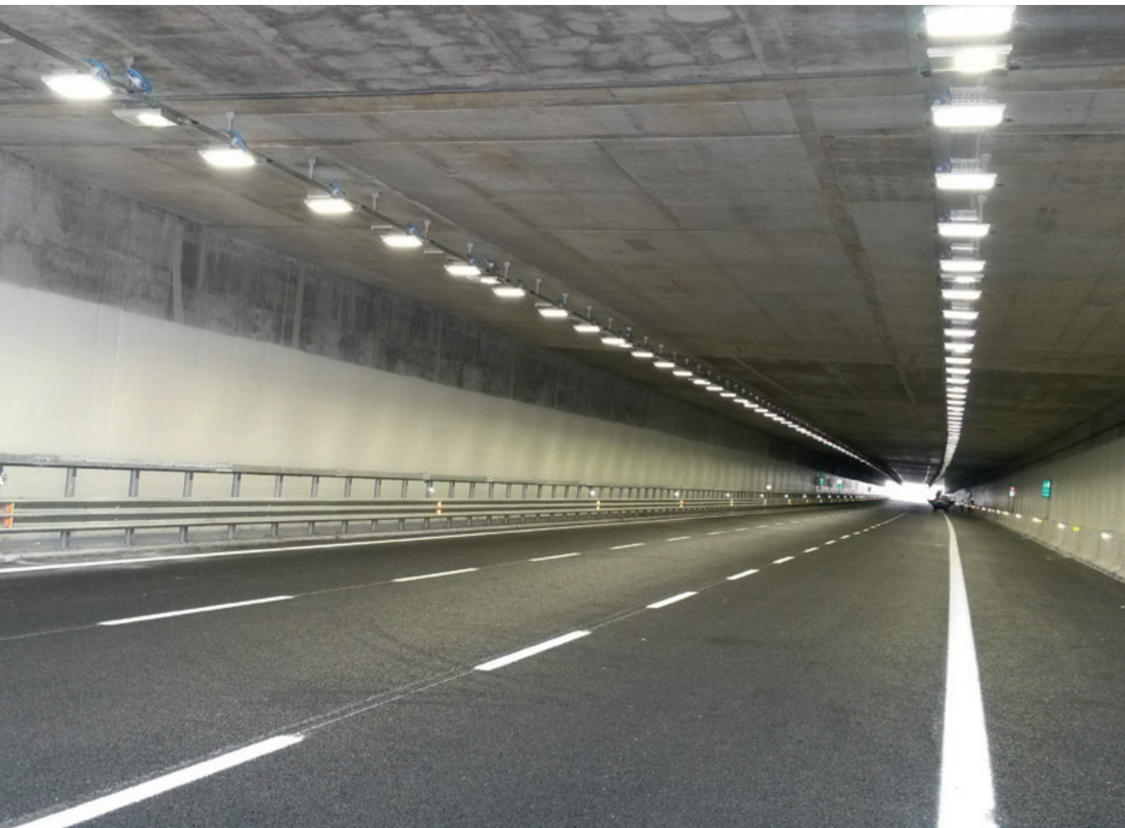
Treviglio tunnel, Romano de lombardia, Italy
